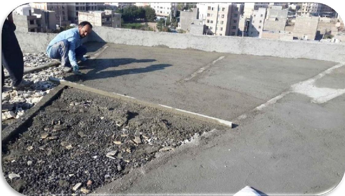
برای جلوگیری از نفوذ رطوبت ناشی از باران و برف در محل اتصال دیوار چان پناه و پشت باه و همچنین سادگی اجرای عایق کار، لازم است گوشه ها و گنج های اتصال را با استفاده از ملات ماسه و سیمان به صورت مورب و با زاویه 45 درجه اجرا نمود. در این حالت آب ناشی از باران یا برف، در گناه دیوار جمع نشده و سریع تخلیه می شوند.
